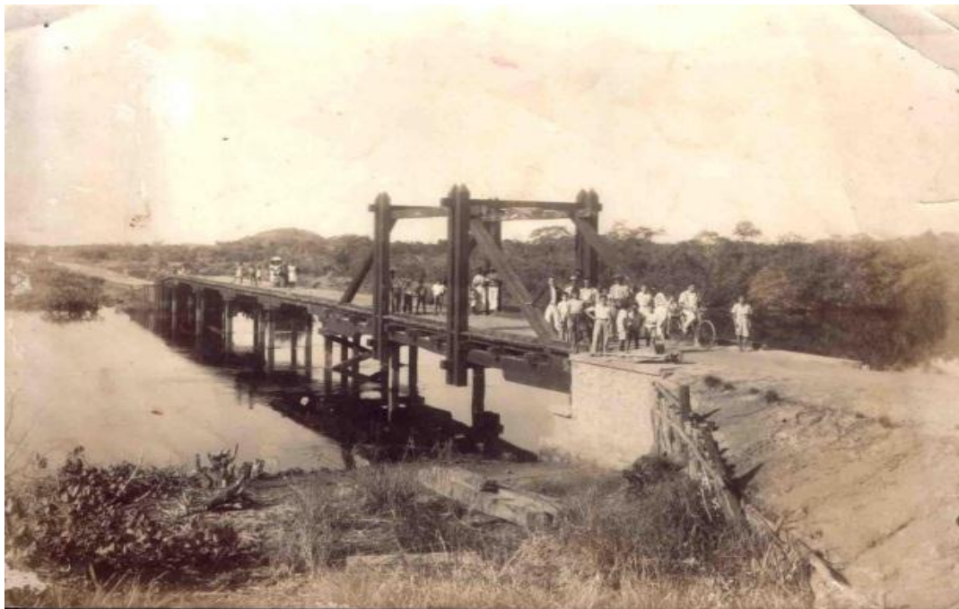
Imagem 16: Ponte construída no início do século XX, com cabeceiras já de cimento.
