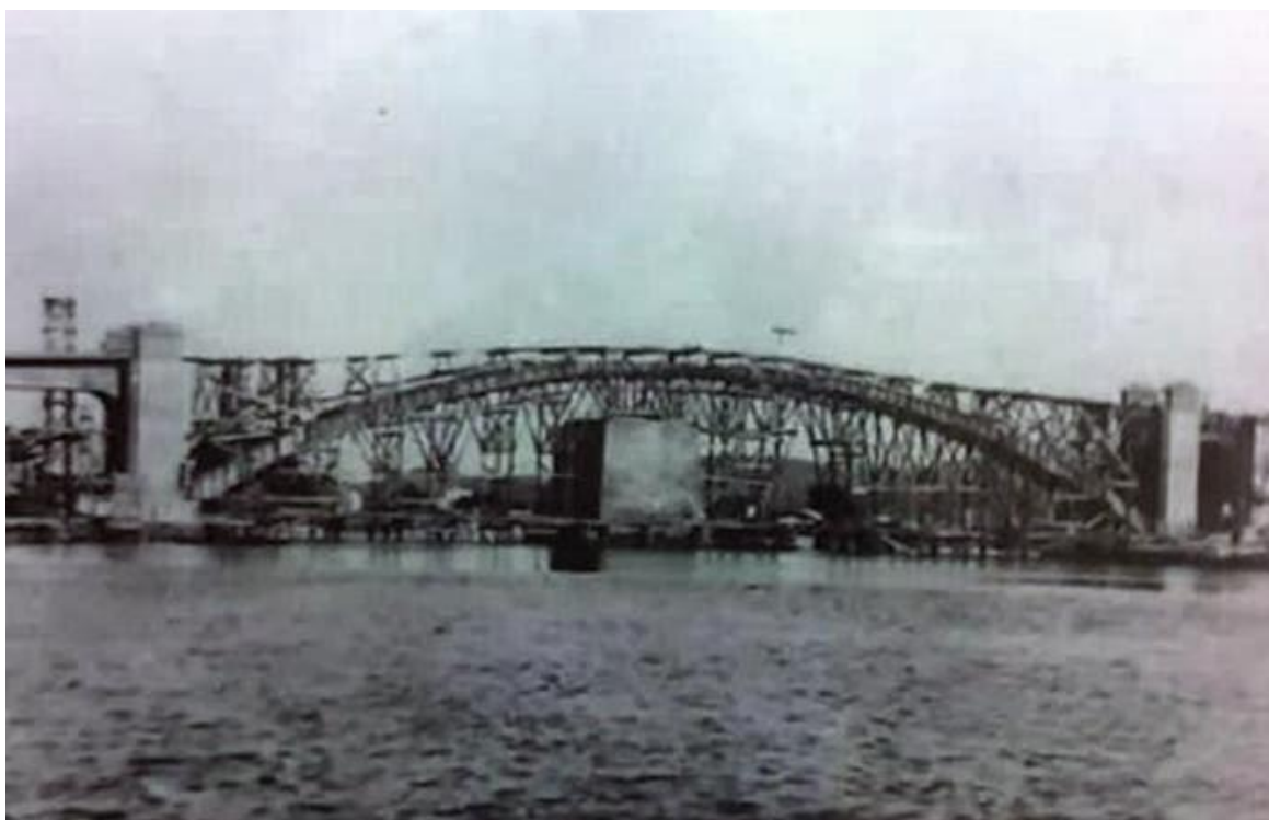
Construção da Ponte Feliciano Sodré 1925 (Wolney Teixeira)
