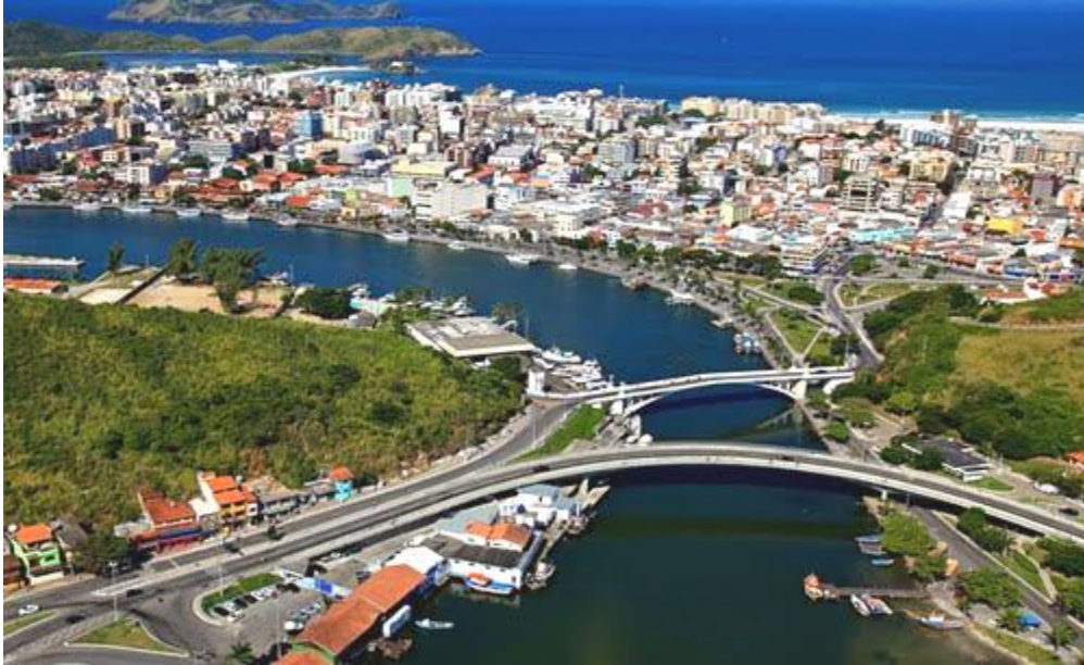
Ponte Feliciano Sodré e Ponte Nova (Fonte: internet)
