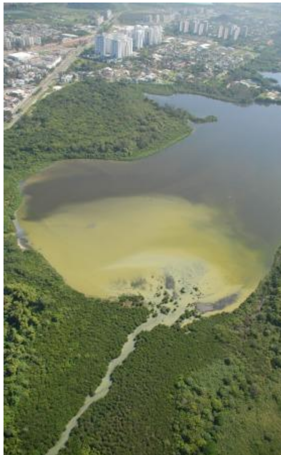
Figura 44: Visão panorâmica da Lagoa de Marapendi e do Canal das Taxas com a pluma de esgoto bem visível pelo tom mais claro na lâmina d'água. Fonte: http://www2.sidneyrezende.com/noticia/116507+lagoa+de+marapendi+sofre+com+poluicao+da+agua . Acesso realizado em 23 dez. 2017
