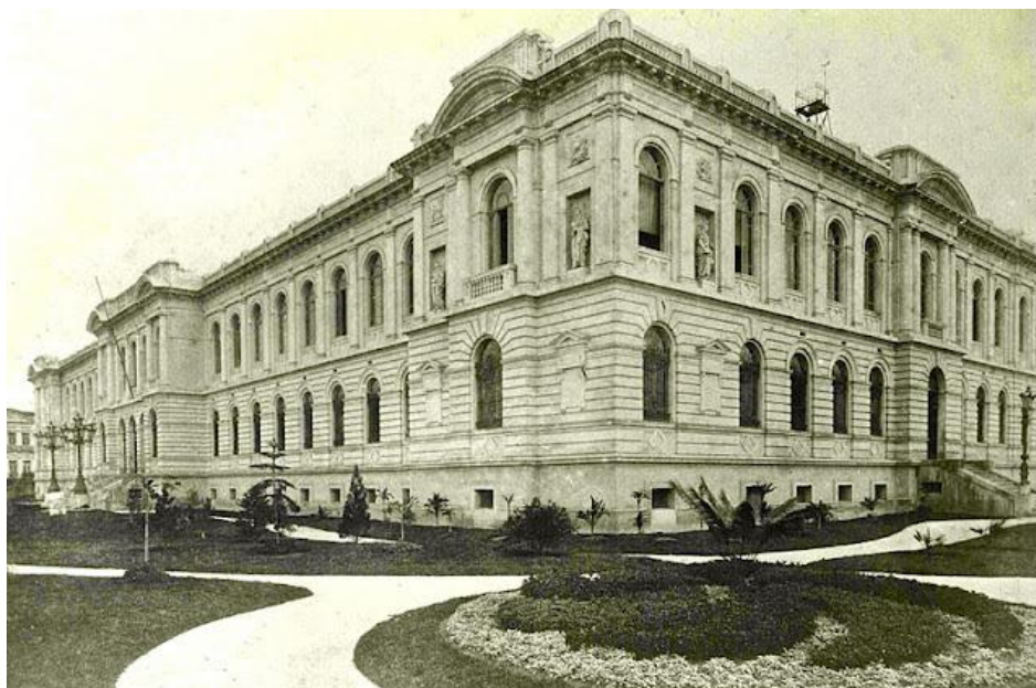
Década de 1910, antes da reforma, o edifício contava apenas com 2 andares.
