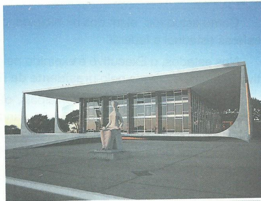
▲ Escultura intitulada A Justiça , de Alfredo Ceschiatti, em frente ao prédio do Supremo Tribunal Federal (STF), na Praça dos Três Poderes, em Brasília (DF). Foto de 2008.
