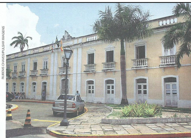
▲ Fachada do Palácio de La Ravardière, sede da Prefeitura de São Luís (MA). Foto de 2007.
