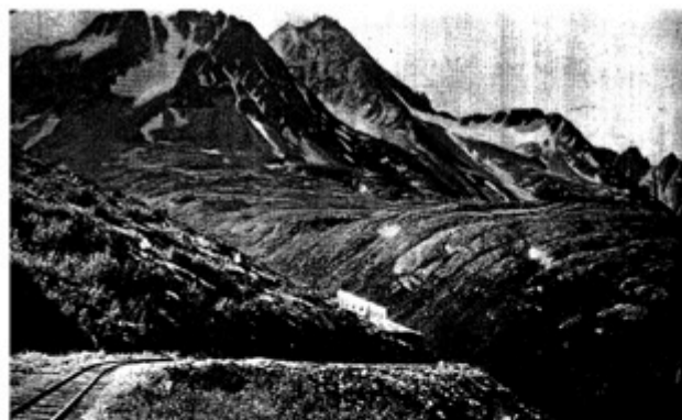
Uma via férrea através das Montanhas Rochosas. [Colorado, EUA] Nesta paisagem de alta montanha, que domina a Cordilheira dos Dentes, se distingue uma via que serpenteia: a linha férrea, ou seja, um fato humano. Sua presença supõe numerosas obras artificiais para alcançar zonas inóspitas e estabelecer relações regulares entre regiões separadas por grandes obstáculos. (tradução nossa) (BRUNHES, 1948, p. 328)
