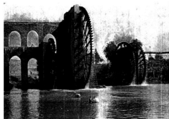
Grandes rodas d'água de madeira em Hama (Siria). A corrente do Rio Orontes é a que move estas grandes rodas que elevam a água para vertê-la nos altos aquedutos. Notem-se as excepcionais dimensões destas rodas d'água. (tradução nossa) (BRUNHES, 1948, p. 316)
