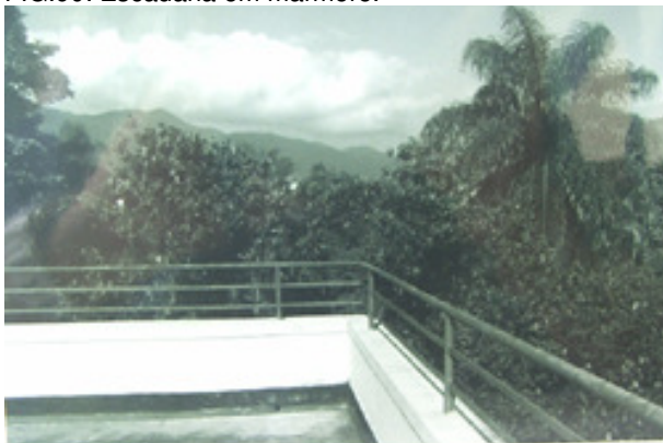
FIG.91: Terraço hoje inexistente devido a acréscimos FONTE: CREP/SME
