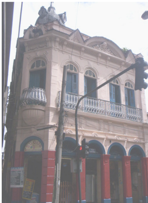
FIG.44: Edificação na Rua Bela. Detalhe da coroa D.Pedro II na cobertura junto ao viaduto da Linha Vermelha. (FONTE: Acervo Particular)
