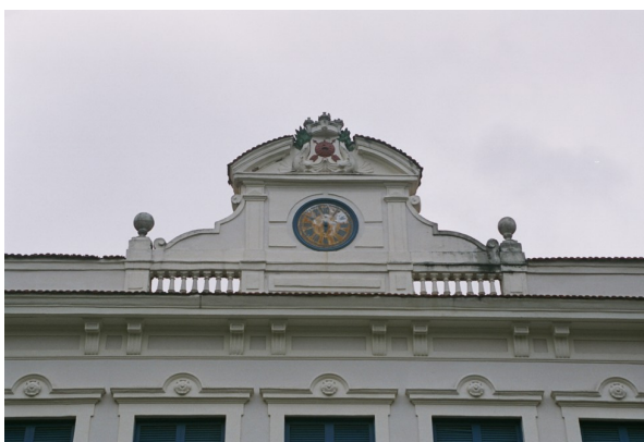
FIG.71-72: Prédio anexo e detalhe do frontão semelhante ao frontão da edificação original.
