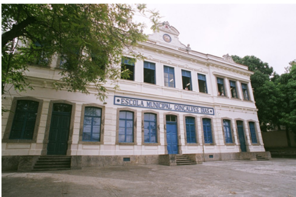
FIG.68: Fachada da Escola Municipal Gonçalves Dias FONTE: Acervo Particular.
