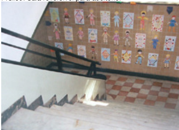
FIG.90: Escadaria em mármore.
