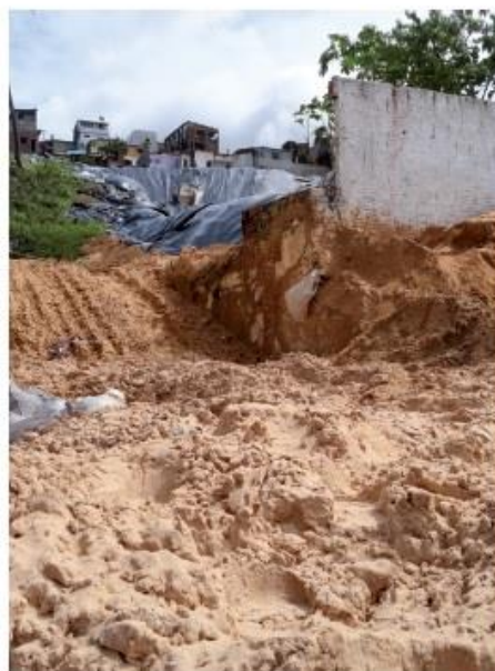
Deslizamento de terra em Natal (RN), 2014.
