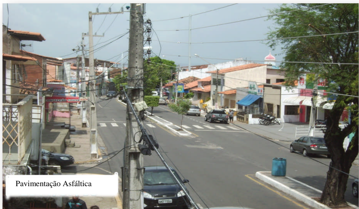
Figura 3 - Av. Gonçalves Dias - Centro da Cidade de São José de Ribamar Fonte: Arquivo do autor, 2011
