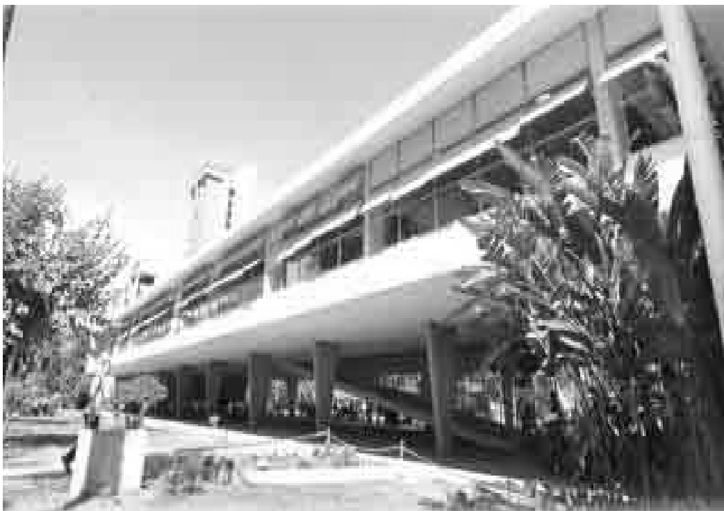
FIGURA 8 – Escola Estadual Governador Milton Campos, localizado na regional Centro Sul (2009)
