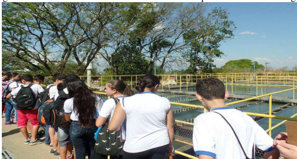
Figura 7: Alunos do oitavo ano B observando os tanques de tratamento de água.
