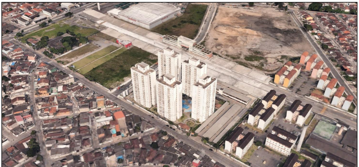
Figura 18 - Boulevard do Parque
