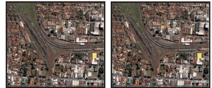
Central de manobras de Estação Ferroviária
