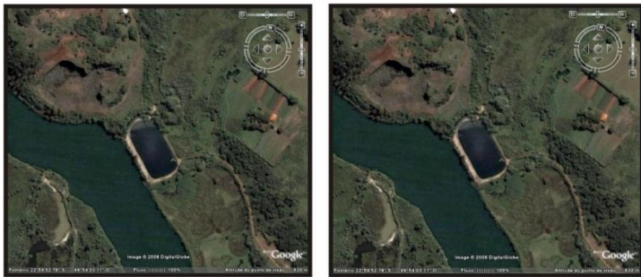
Lagoa de decantação
