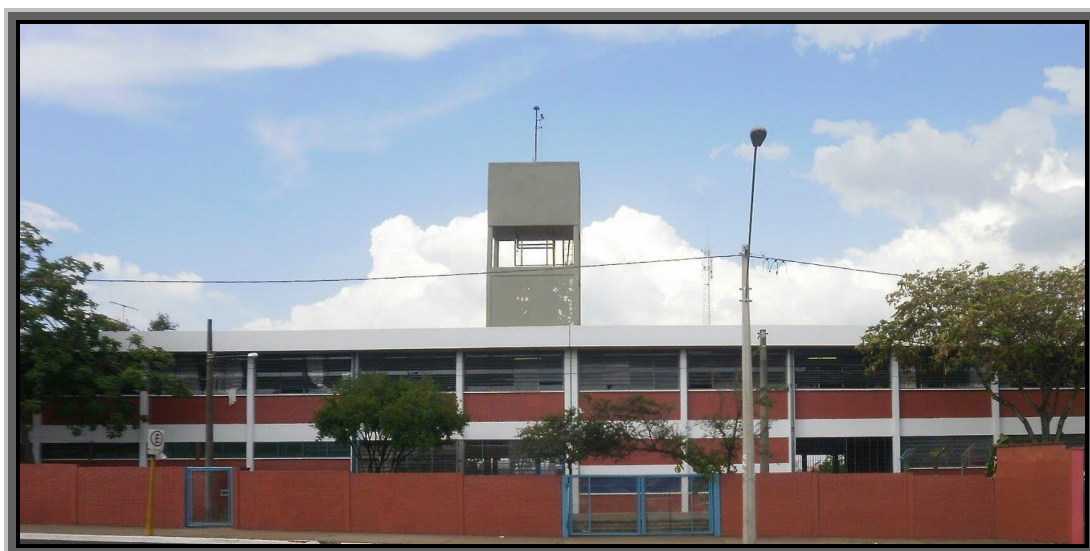
Figura 3 - Fachada principal da EE Professora Ada Cariani Avalone. Fonte: acervo da escola.
