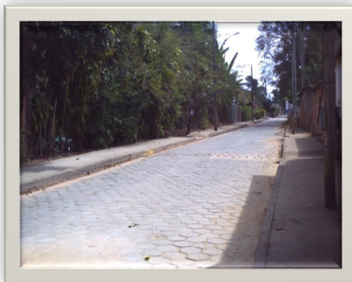
Foto 1: Rua principal do Batatal 14
