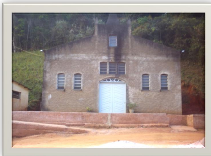
Foto 9: Igreja Católica do Batatal em obra
