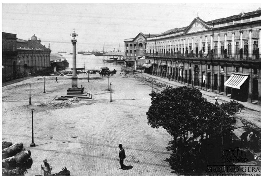
Figura 10 - Fotografia Cais do Valongo início século XX
