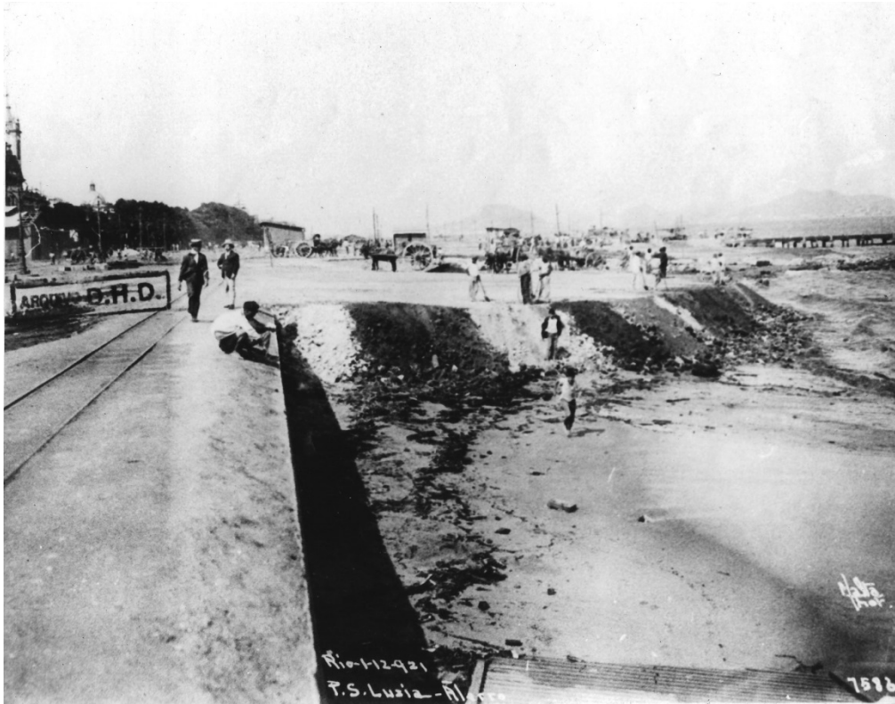
Figura 4 - Fotografia do Aterro da Praia de Santa Luzia
