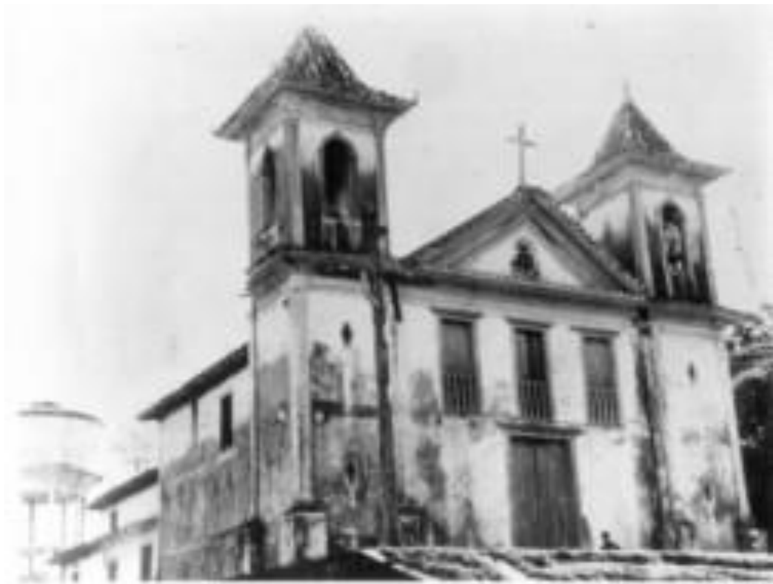
FIGURA 11 – Antiga Igreja do Rosário (Demolida em 1974)
