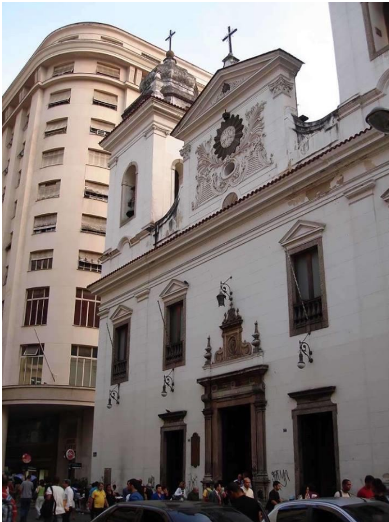
Fachada da Igreja em seu estado atual. Foto disponível no site do Museu do Negro, acessado dia 28/07/2016: http://www.museusdorio.com.br/joomla/media/k2/galleries/40/00_LM.JPG
