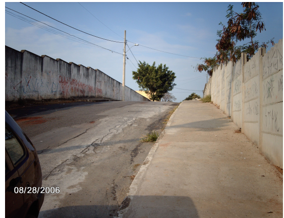
Figura 29: Muro da Escola E4
