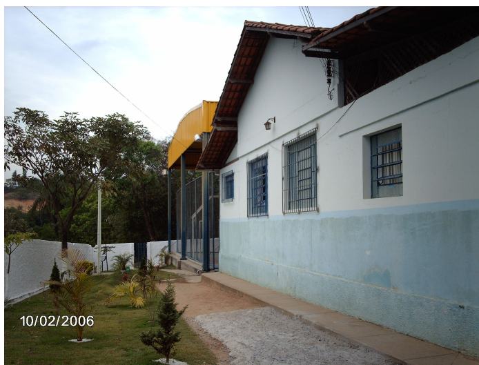
Figura12 : fachada da Escola E1
