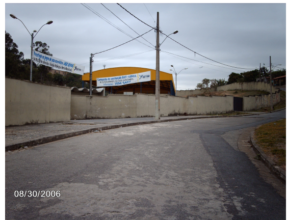
Figura 33: muro da Escola E5
