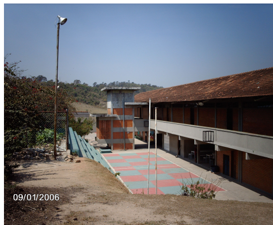
Figura5: fachada da Escola E10
