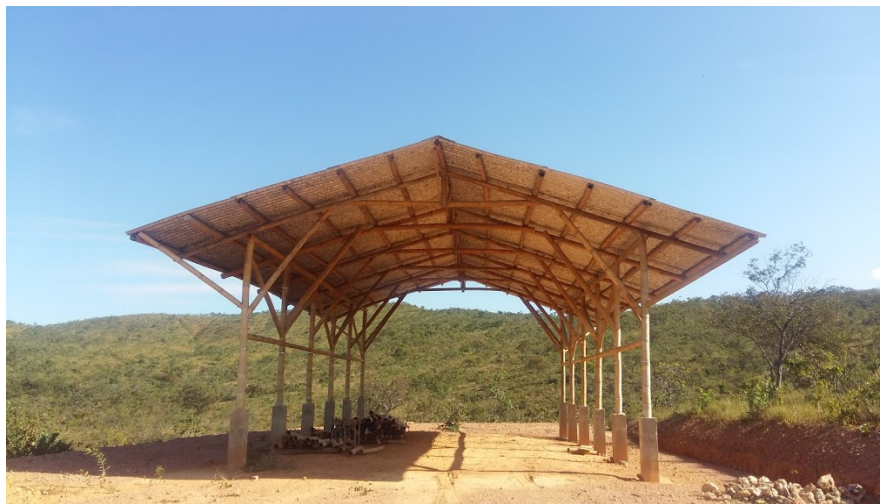
Foto 11: Estrutura em bambu tratado que abrigará a casa comunitária do coco macaúba na comunidade do Berto. Foto autora, 2017.
