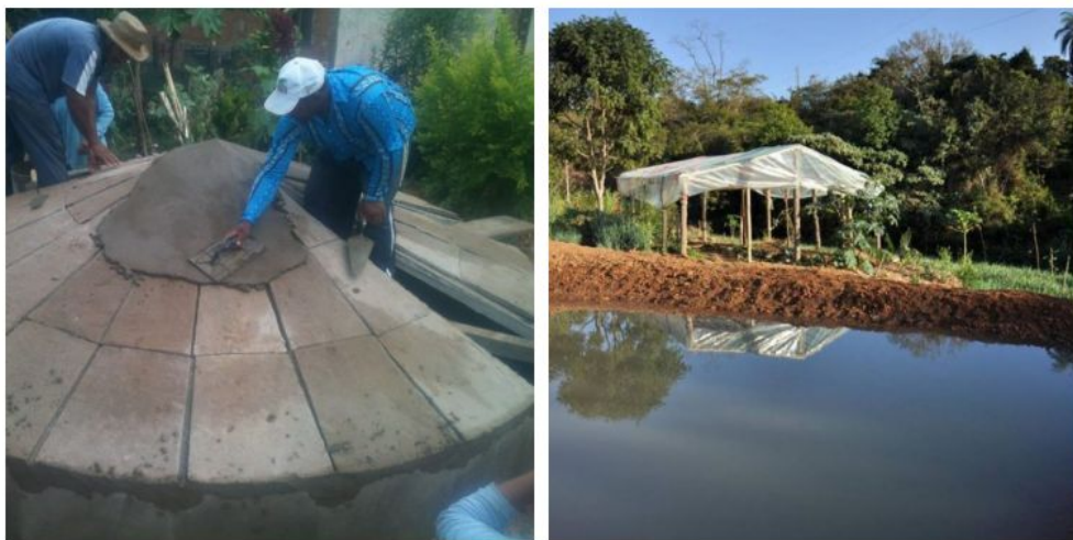
Foto10: Projetos da Amanu: à esquerda, construção de cisterna de 16 mil litros para captação de água da chuva. À direita, lago de peixes e estufa construídos em parceria com o projeto Barraginhas/Embrapa. Fotos Amanu divulgação, 2017
