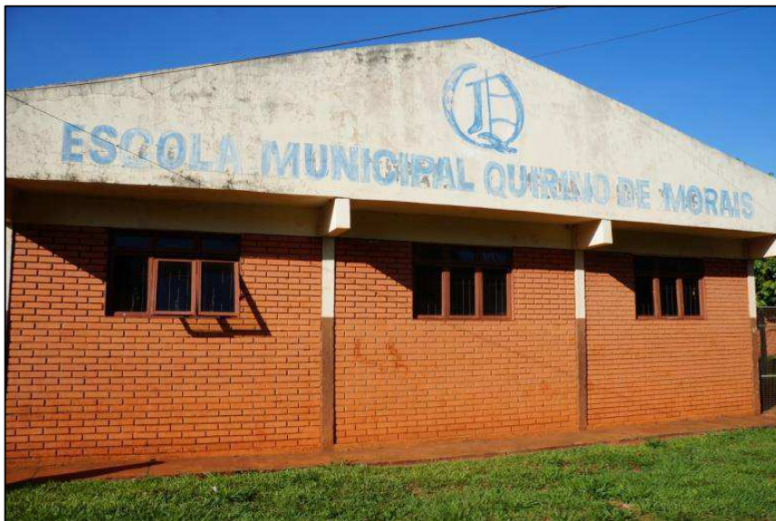
Foto 1 – Ituiutaba/MG: vista parcial da Escola Municipal Quirino de Moraes, 2017
